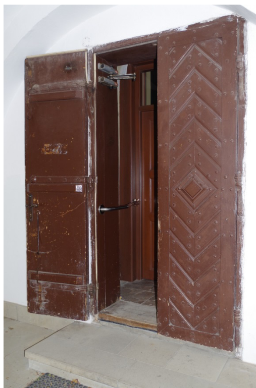
Fot. 2. Wejście boczne do lewej nawy.
