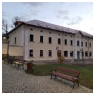
Zdjęcia z budynku kamienicy i budynków gospodarczych
